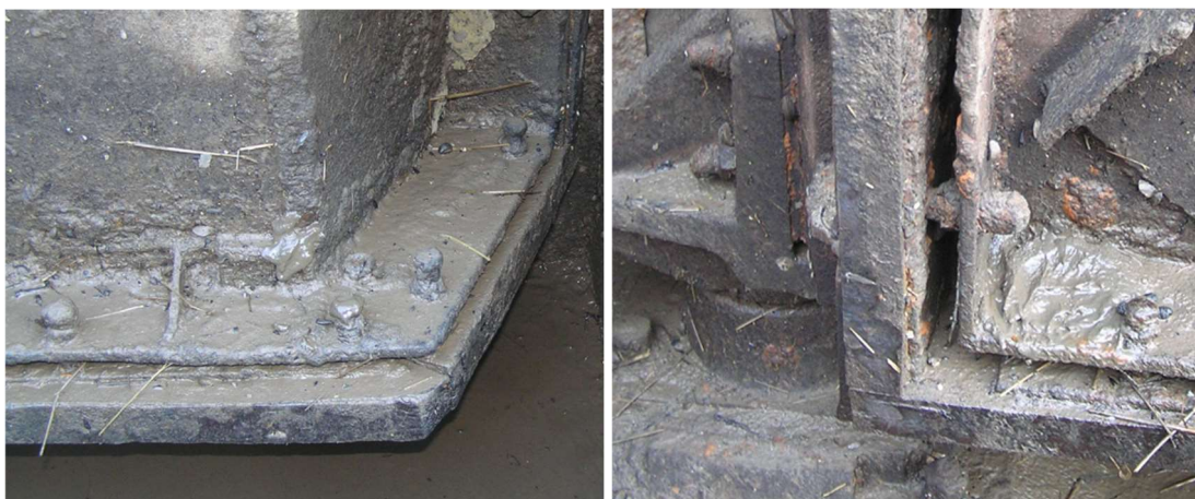
Technické řešení prahového těsnění na srazu a v rohu
