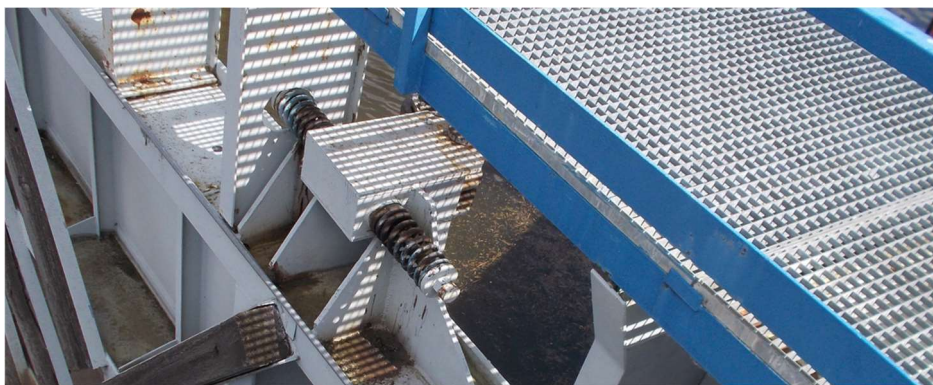
Dispozice odpružení a lávky, montáž lávky na vrata
