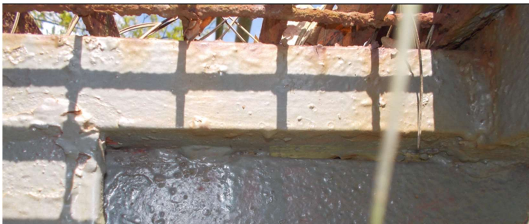
Technický stav konstrukce lávky - svary
