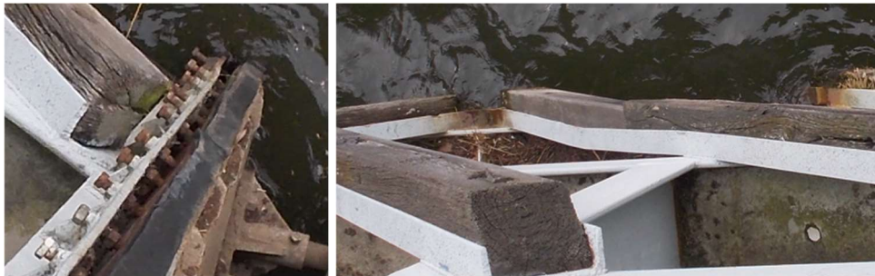
Pozorované deformace nosičů těsnění a diagonál
