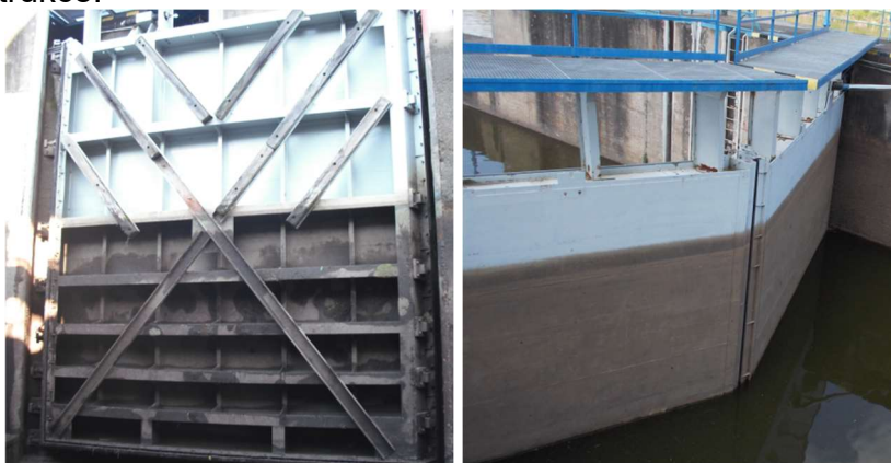
Vzpěrná vrat s povodní a návodní strany
